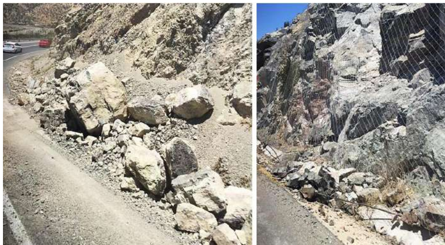
Figura N°4: Desprendimientos de rocas en ruta 41-CH sector embalse Puclaro, Región de Coquimbo, Chile, tras el terremoto de Coquimbo de enero de 2019 de 6.7 Mw según el Centro Sismológico Nacional. Fuente: Palma (2019).
